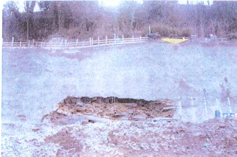
Foto Y - Inizio del movimento franoso
